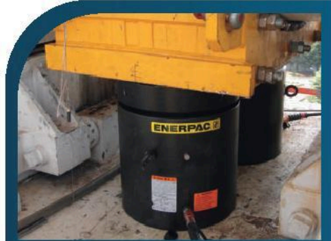
Vérins écrou de sécurité de 50 à 400 T
